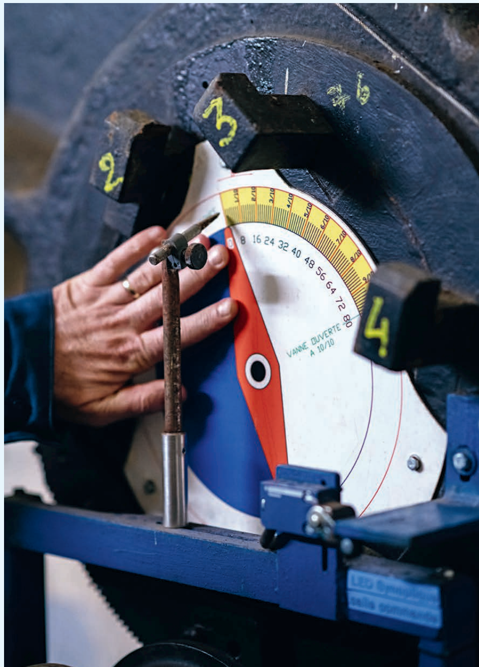
Indicateur de position de la lentille, vanne de fond, barrage de Saint-Étienne-Cantalès
